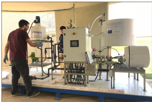
FIGURA 9. Planta pilot AD-MEC instal·lada a l'EDAR de Lleida. Fotografia dels autors.
